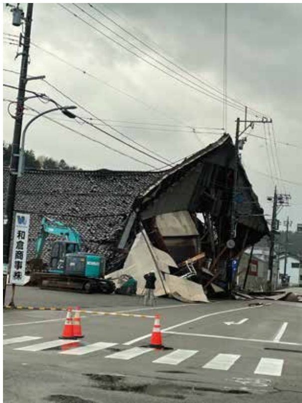
■ 和倉温泉地区では、家屋の倒壊が深刻だった。写真／濟一
